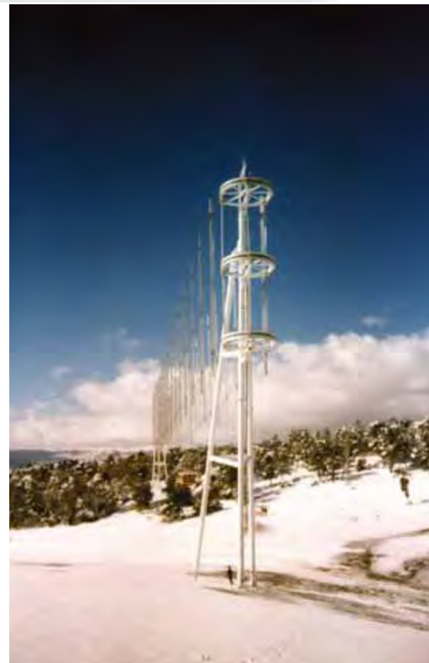
Arriba, el aerogenerador de traslación, en el Valle de Losa, Burgos.
