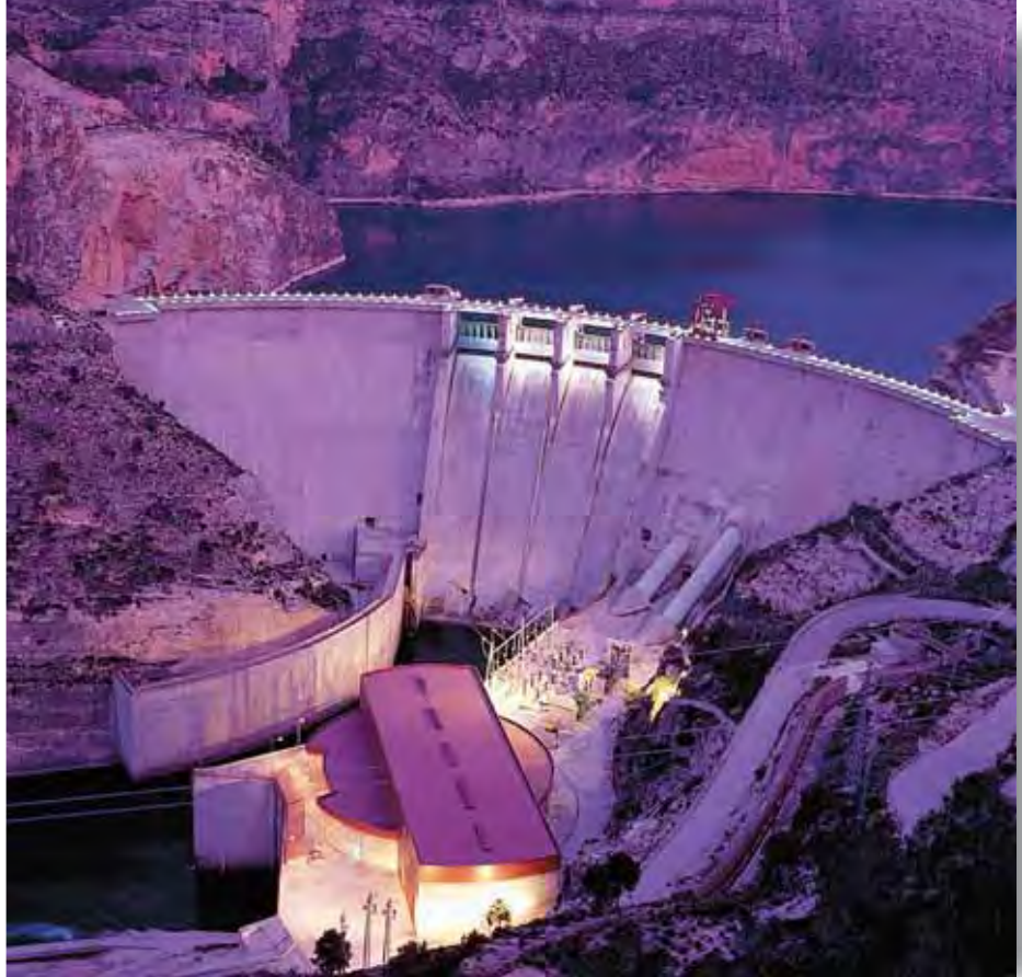
En página anterior, instalaciones de bombeo del embalse de Bolarque en el río Tajo, de Unión Fenosa. Arriba, la mayor central hidroeléctrica de bombeo de Europa, la de La Muela II en la margen derecha del Júcar (en Cortes de Pallás, Valencia), de Iberdrola.
