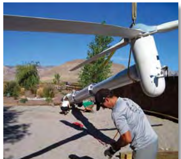
Instalación de un mini aerogenerador en Nevada, Estados Unidos.
