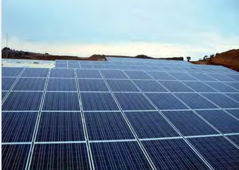
Paneles solares en el estado de Veracruz. Existen en el país 5.712 MW instalados de módulos fotovoltaicos, con 5,2 h/día promedio de insolación, uno de los más altos del mundo.
