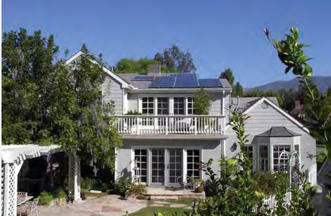
Instalación solar fotovoltaica doméstica de Martifer Solar en Pasadena, California.
