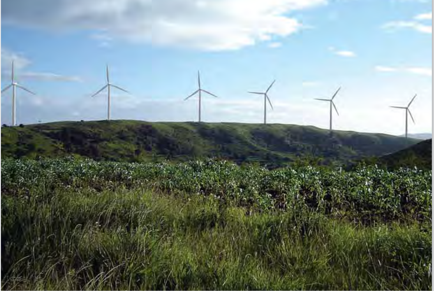
Parque eólico en Cerro de Hula, Honduras.
