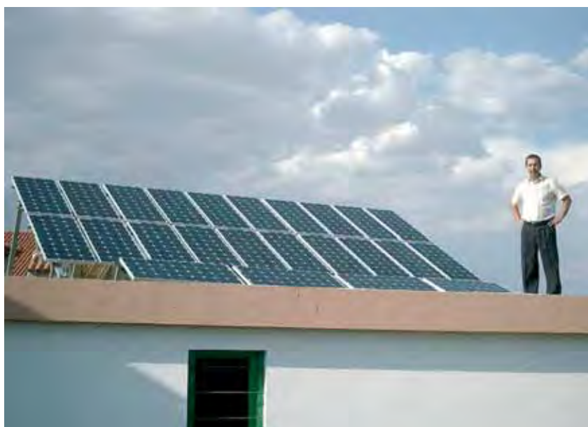
En la foto uno de los lectores de los que hablábamos en el número 40, Julio Berzal, posando en su tejado junto a la instalación solar que fué, según contábamos, la primera en conectarse a Iberdrola.
